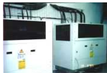
Transfo 2000 Kva Le Méridien Nouméa
