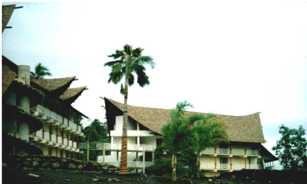
Le Méridien Punaauia en construction
